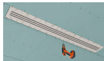
Důležité: Při instalaci je nutné všechny upevňovací šrouby zcela dotáhnout.
